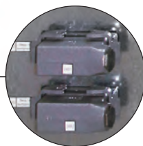
Испытательные разъемы выходных реле
